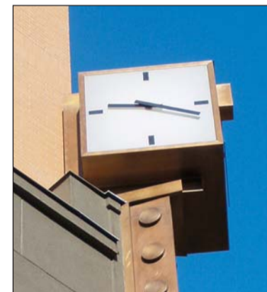
Velké hodiny na rohu budovy nejsou žádnou novinkou: postupem času po nich však zbyl jen mosazný podstavec. Nyní je na nároží osazen moderní hodinový stroj ve stylu art déco, který funguje podle signálu z rozhlasu.
