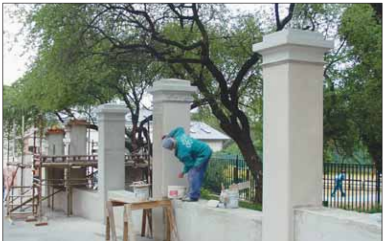
Práce na obnově oplocení v květnu 2004
