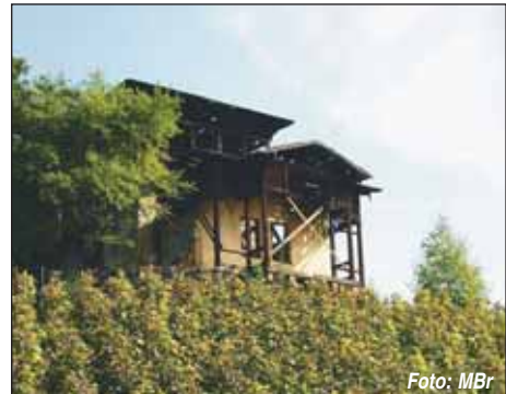
Altán před rekonstrukcí v r. 2002...
