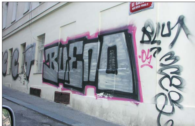
Ulice Ke Karlovu po řádění sprejů...
