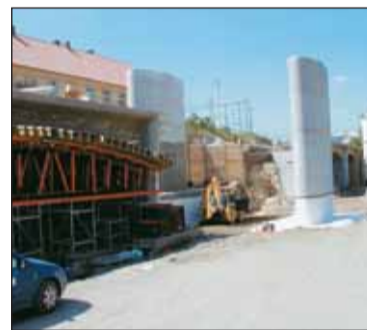
Přilíže železniční estakády nad rozšiřovanou Husitskou ulicí Foto: Vojtěch Klouček
