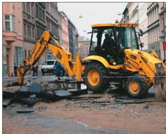
Oprava prasklého potrubí v Sokolské
